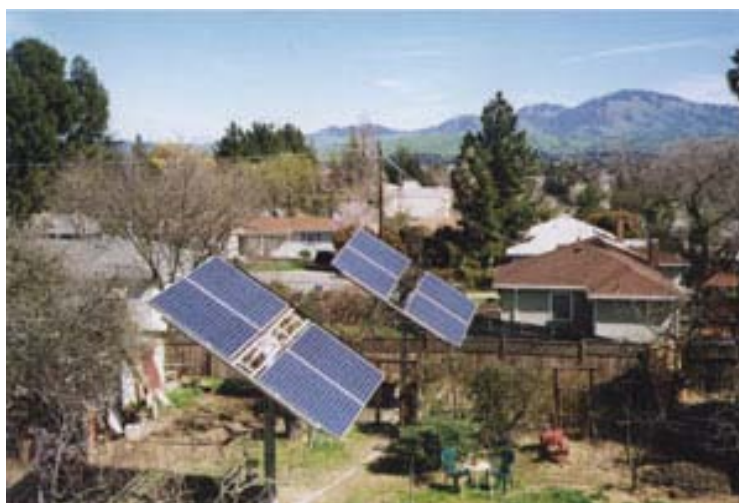
Slika 30. Dvorišna instalacija pasivnih, jednoosnih sustava za praćenje. Sustav je prikazan u zimskom položaju, nagnut prema jugu. Visoki nosači omogućavaju prolazanje i iskorištavanje prostora ispod fotonaponskih panela za sadnju biljaka, koje su onda zaštićene od jakog podnevnog Sunca [4].
