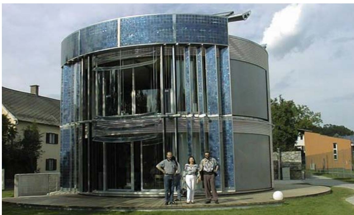
Slika 33. Gemini House u cijelosti rotira oko svoje osi i solarni paneli se rotiraju neovisno o kući, dopuštajući kontrolu prirodnog grijanja od Sunca [4].
