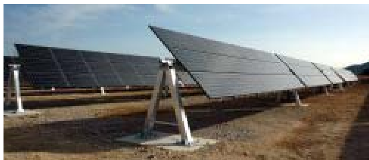
Slika 32. Wattsun HZ-serije linearni sustavi za praćenje u Sjevernoj Koreji. Ovi sustavi za praćenje koriste horizontalnu os [4].
