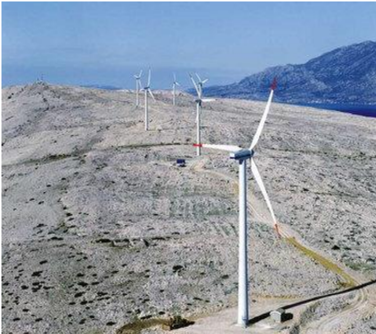
Slika 3. Vjetroelektrana Ravne 1 na otoku Pagu
